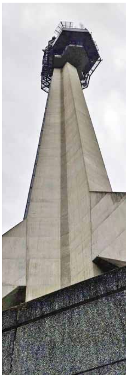
250 Meter ragen in den Himmel
